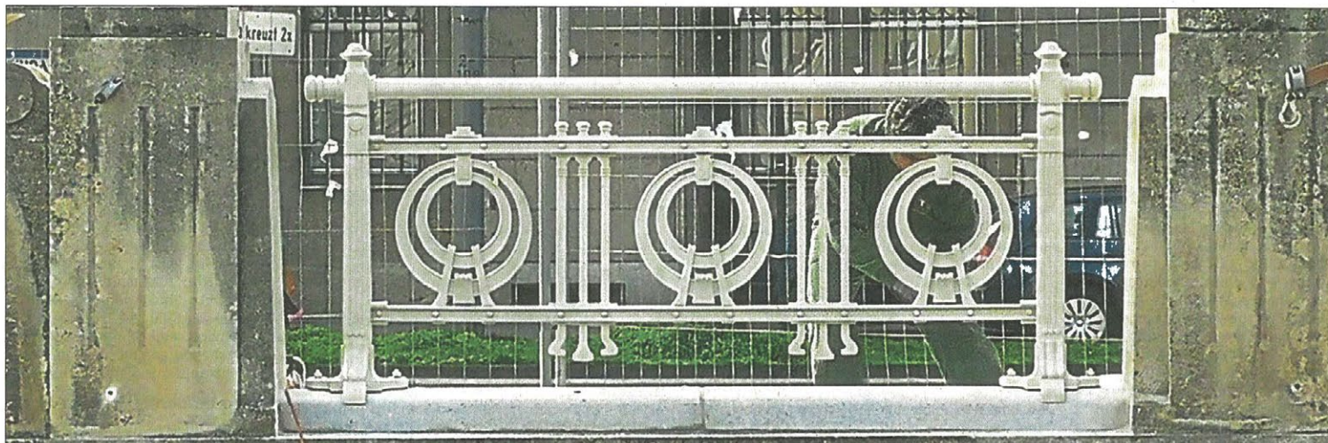
Zweieinhalb Meter Donaukanalgeländer, wie es zur Errichtungszeit ausgesehen haben muss: am Franz-Josefs-Kai, beim Treppenabgang zum Badeschiff.
